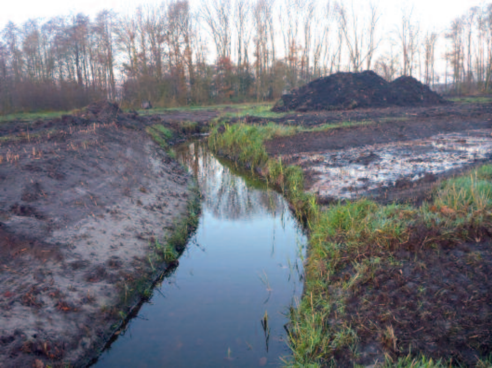
Foto 4. Verondieping van het Scheebroekenloopje door aanpassing van het stroombed (foto: Peter Paul Schollema).
