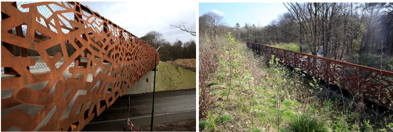
Figuur 2.27 Op het brugdek van Natuurbrug Hoorneboeg zijn de 1,8 m hoge faunakerende rasters geïntegreerd in de randafwerking met een takkenstructuur. Het aanzicht van de noordelijke rand (links) en de achterkant van de zuidelijke rand (rechts). © Foto's: E. van der Grift.
