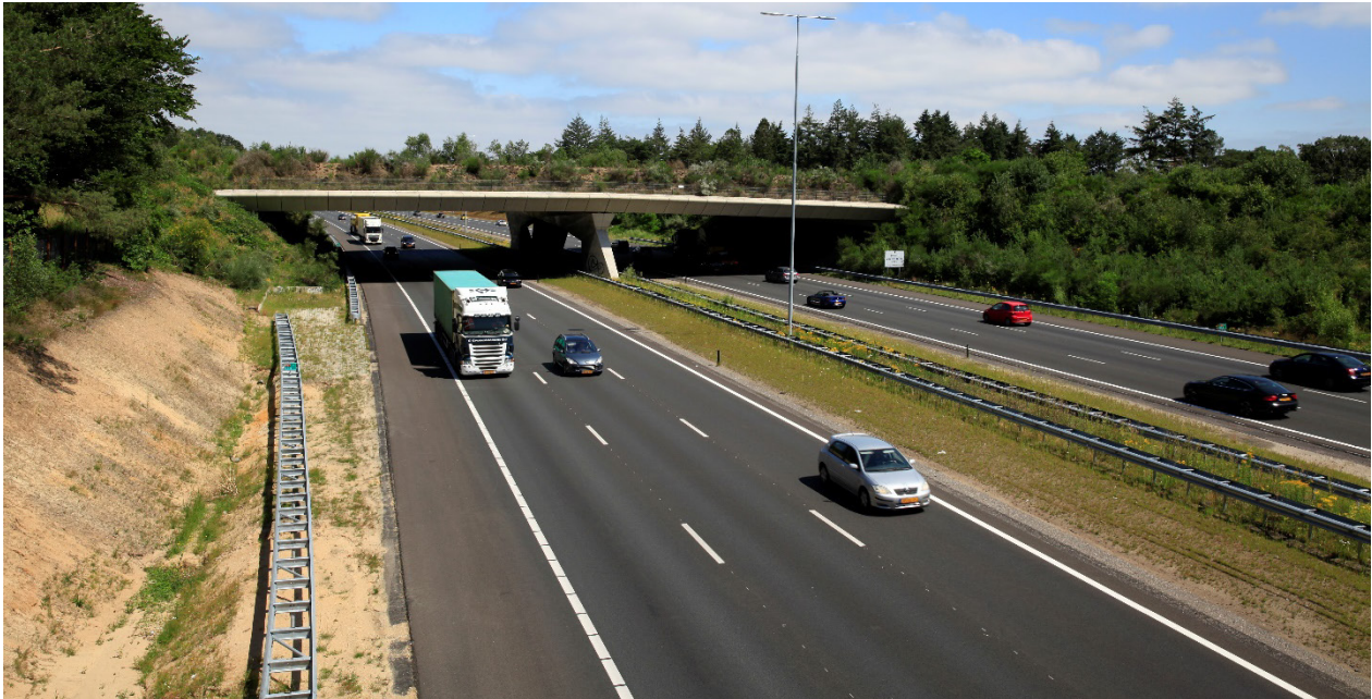
Figuur 2.4 Autosnelweg A27 ter hoogte van de kruising met de natuurverbinding na de wegverbreding in juni 2019, met 2x3 rijstroken. © Foto: E. van der Grift.
