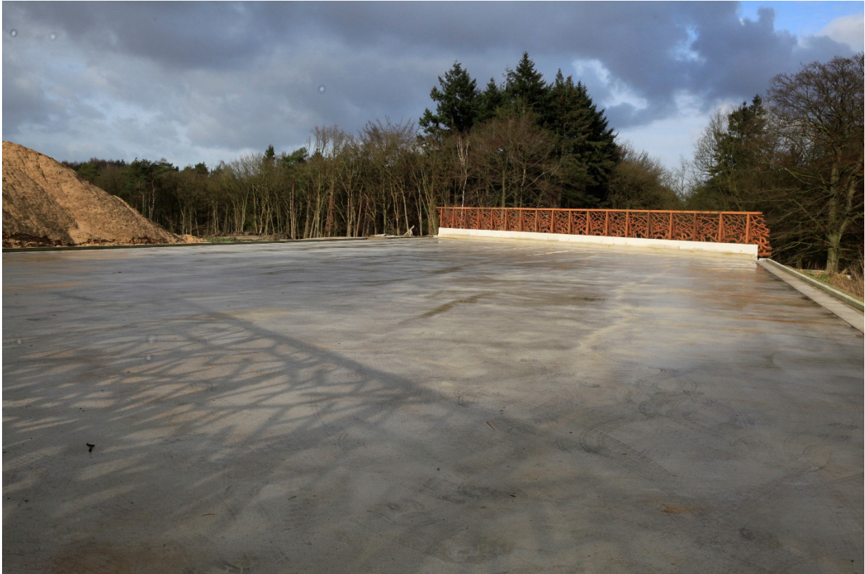
Figuur 2.20 Het brugdek van Natuurbrug Hoorneboeg, nog zonder de leeflaag, in januari 2015. © Foto: E. van der Grift.
