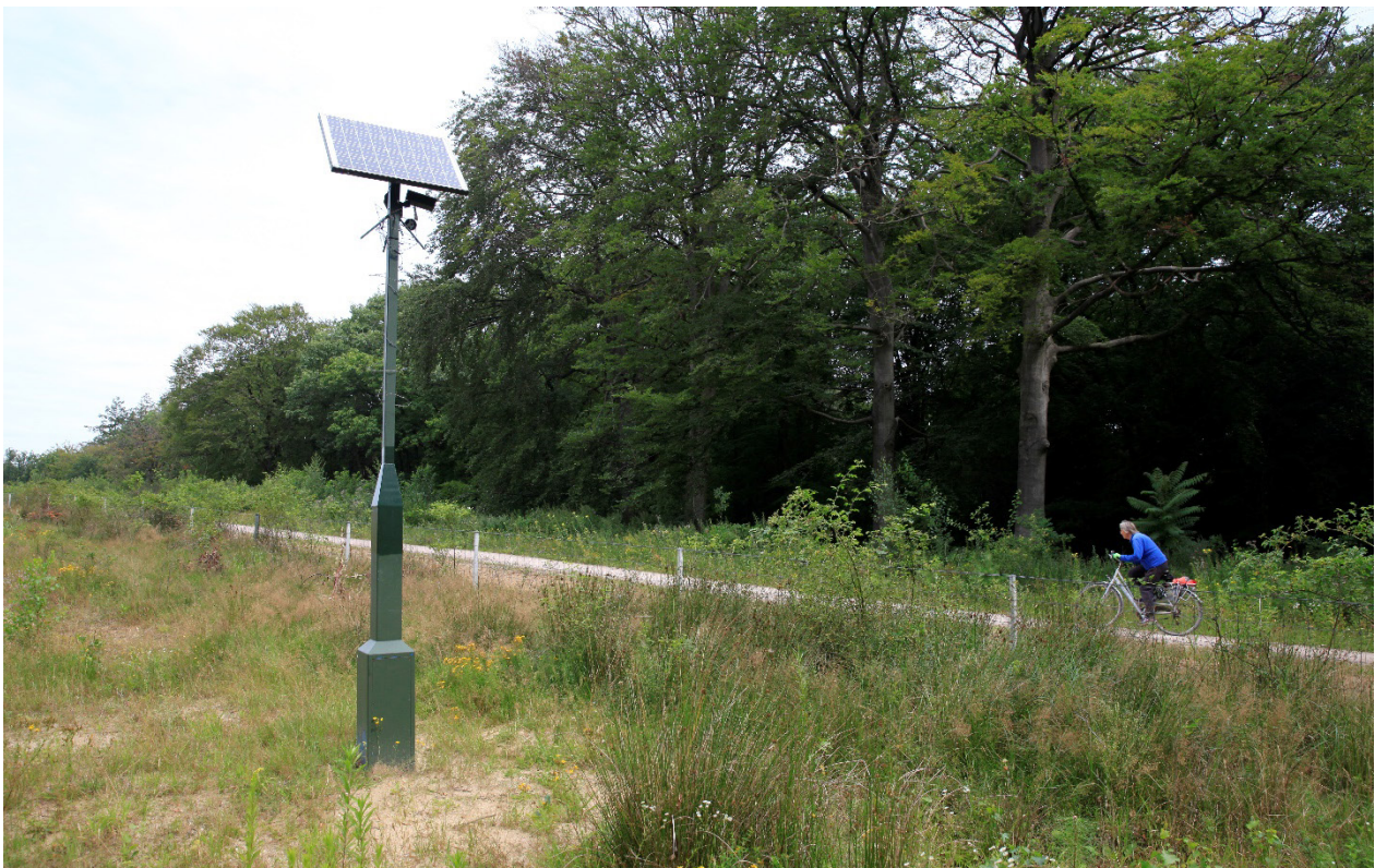
Figuur 5.5 De cameraopstelling – met camera H9 en H10 in een hoge paal – voor de monitoring van het ruiterpad en gecombineerde fiets-/voetpad op Natuurbrug Hoorneboeg in 2020. © Foto: E. van der Grift.
