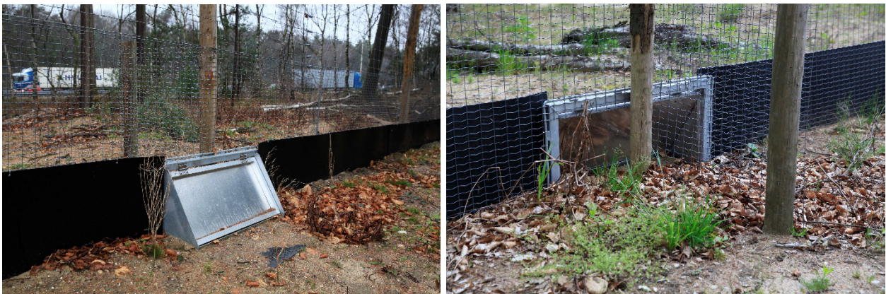
Figuur 2.19 Een dassenpoort gezien vanuit het natuurgebied (links) en vanuit de wegberm (rechts). Deze voorziening moet middelgrote dieren, zoals dassen, in staat stellen om de wegberm te verlaten, mochten zij daar toch op een of andere wijze in terechtgekomen zijn. © Foto's: E. van der Grift.
