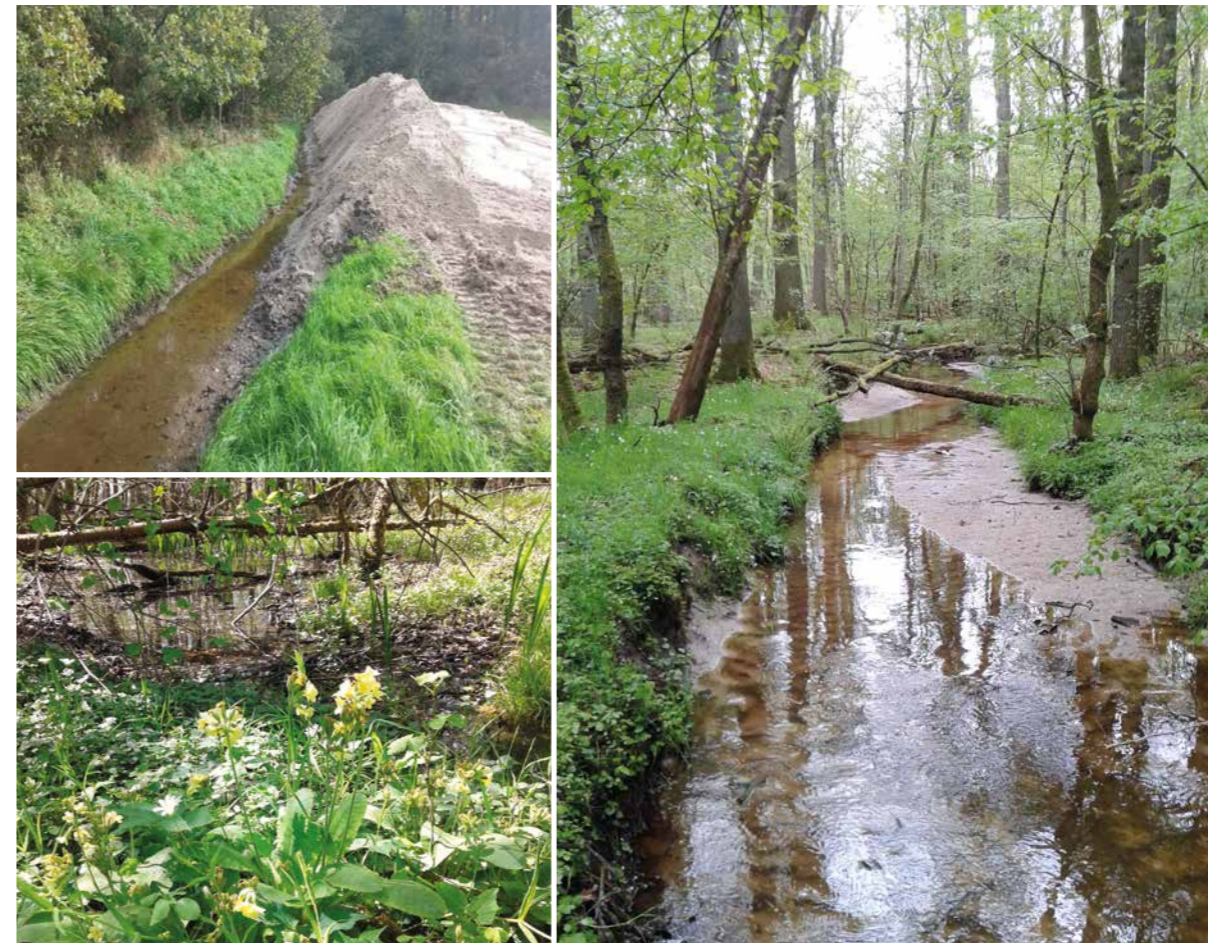
Zanddepot langs de Snoeyinksbeek en beek direct benedenstrooms na zandsuppletie. Hetzelfde traject een jaar na herstel met in het beekdal en op het vers gesuppleerde zand uitbereiding van onder andere, slanke sleutelbloem, kensoorten van het Eiken Haagbeukenbos. Foto's: RVD
