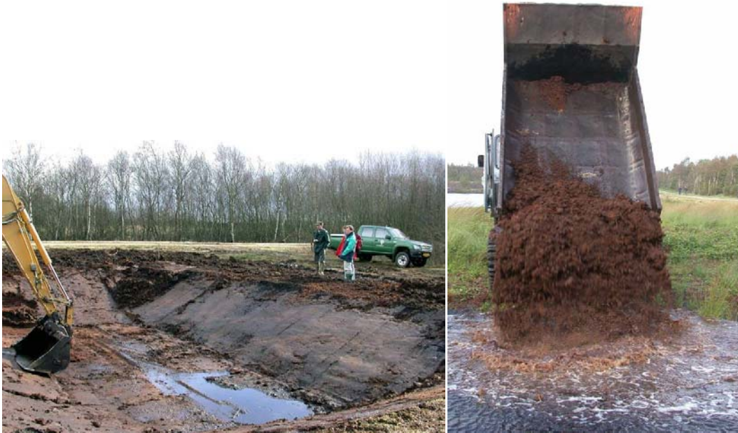
Figuur 32. Opschaling van experimentele drijftilvorming via de introductie van veensubstraat: in februari 2004 zijn hiervoor in het verveende deel van het Meerstalblok (Bargerveen) vijf zwartveenputten gegraven van 5 bij 10 meter (links) waar in september 2004 witveen is ingebracht (rechts).
