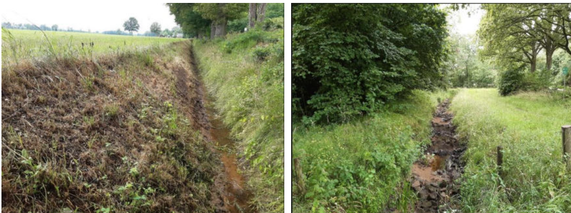
Figuur 4.1. Links: Diepe insnijdingen van de bovenstrooms gelegen waterlopen hebben grote invloed op het systeem (drainerend effect en piekafvoeren). Rechts: Verondiepen en piekafvoeren afremmen als voorbeeld bovenstrooms.
