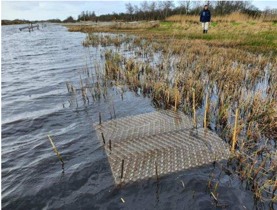
Figuur 7.3.4. De aan de rand van de kragge geplaatste BESE-elementen.
