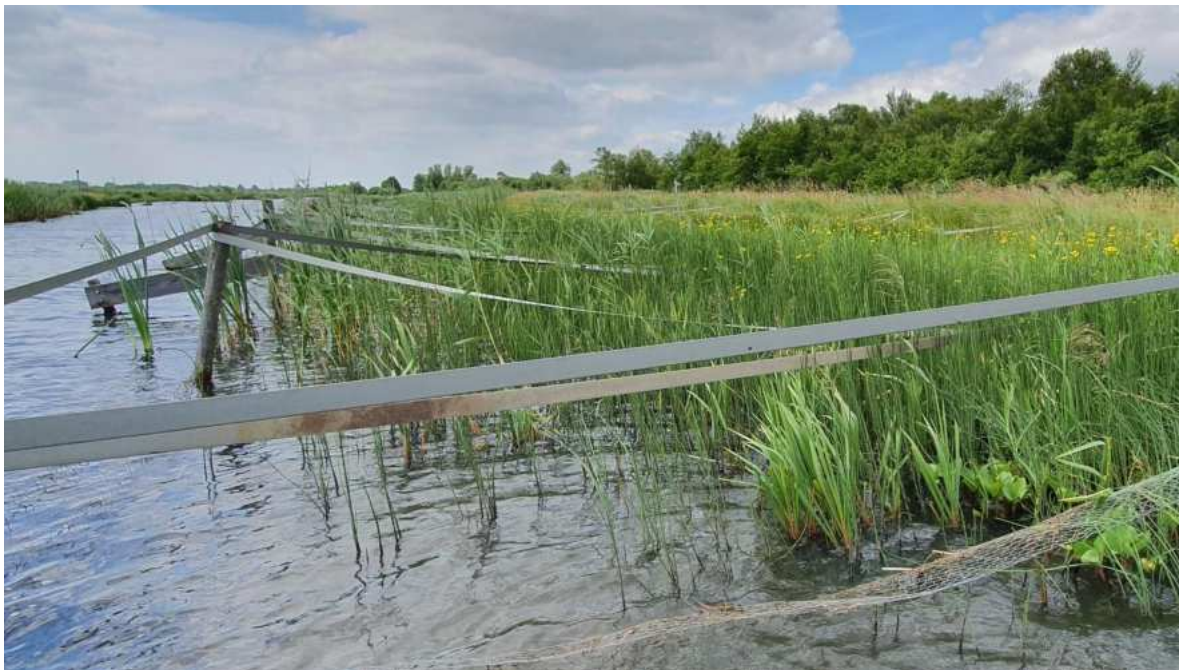
Figuur 7.4.11. Uitbreiding van de kragge in de PQ's met gaas+lint tot juni 2021. Bij aanleg stonden de palen links ongeveer 4 meter van de rand van de kragge.
