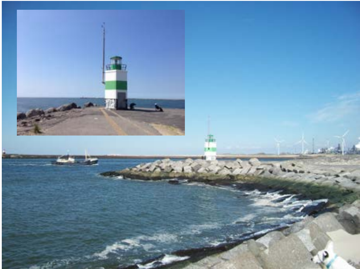
FIG. 1.2. De KNMI-windmast op de zuidpier van IJmuiden (foto Stuyfzand 2014). Locatie aangegeven op kaart Fig.1.1.
